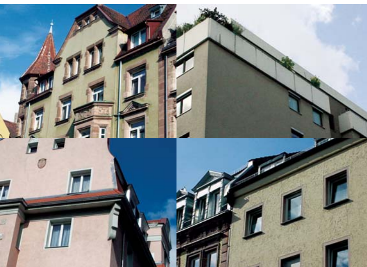
Beispiele von Brutgebäuden in Nürnberg
