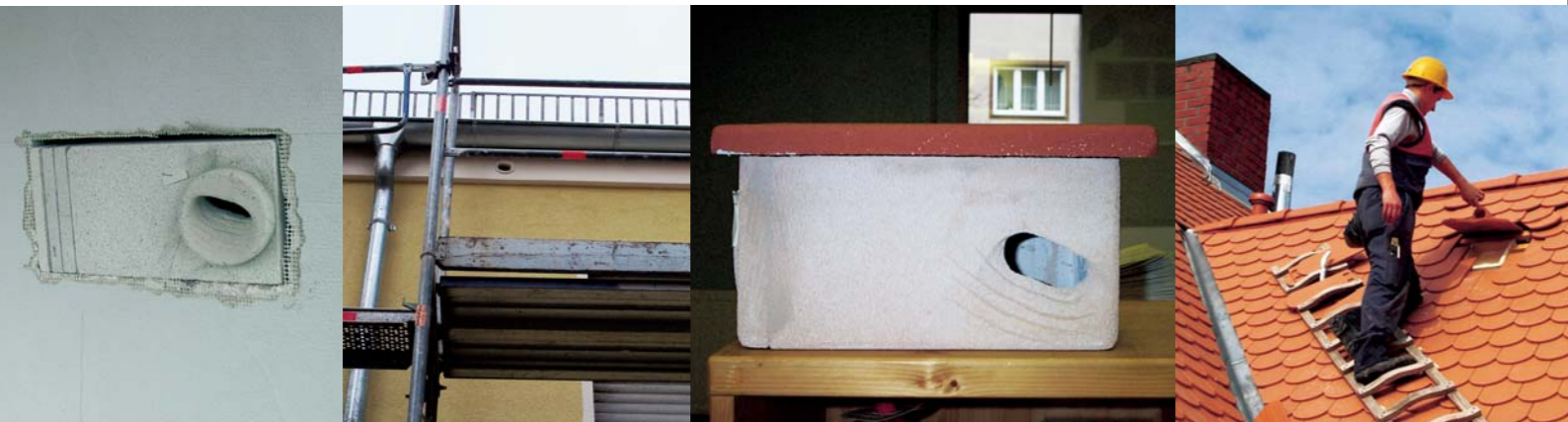
Einpassen eines Niststeines und Frontansicht nach Einbau
